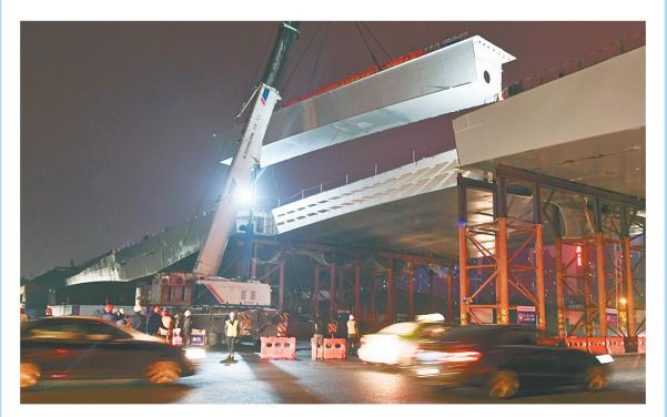
本报讯(记者 黄永东 文 周甬 图)备受关注的107辅道(东三环) 快速化工程再传捷报。10月23日 深夜,高架主线桥上跨金水路174 米钢箱梁完成最后一块箱体吊装, 顺利实现合龙。这标志着107辅
