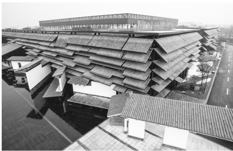
空中俯瞰乌镇互联网国际会展中心(10月26日摄)。 第三届世界互联网大会将于11月16日至18日在浙江省桐乡市乌镇举办。据了解,作为世界互联网大会永久会址——“乌镇互联网国际会展中心”已经全部完工,灯光、网络等硬软件设备也全部调试完毕,静待世界互联网大会开幕。新建成的“乌镇互联网国际会展中心”由“普利兹克建筑奖”获得者、中国美院教授王澍领衔设计,建筑面积8.1万平方米,由会议中心、接待中心和展览中心三个功能区块组成。 新华社记者 徐昱摄
