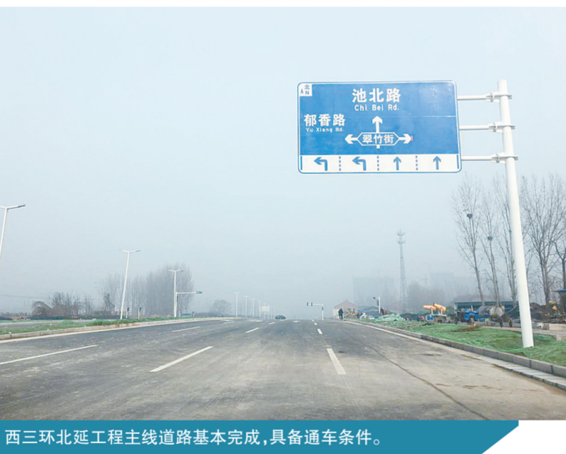
西三环北延工程主线路基本完成,具备通车条件。
