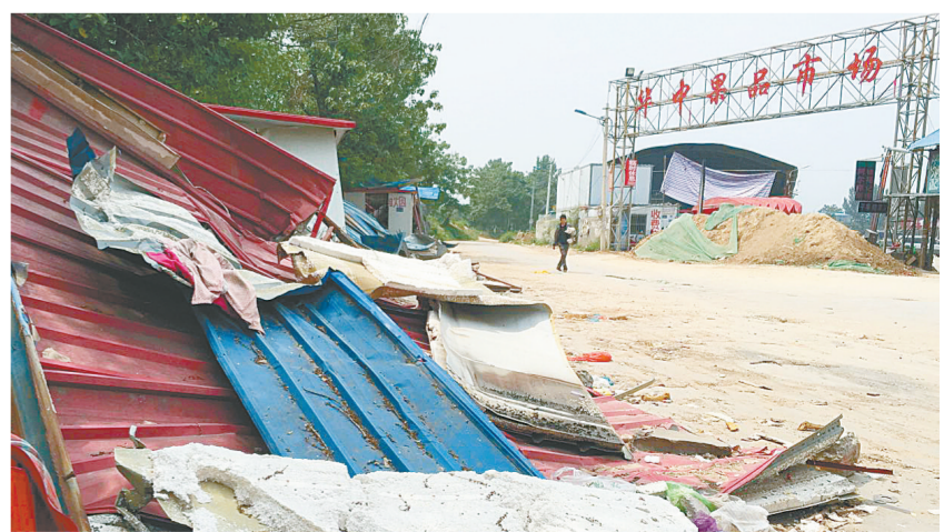
拆除的简易房随意堆砌
