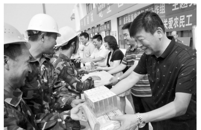
昨日,惠济区老鸦陈街道联合区直第四党建协作组及区委组织部、人社局等部门,在中建七局项目工地组织开展主题党日,为顶酷暑忙在施工现场一线的农民工兄弟送来防暑降温慰问品,并进行劳动保障政策宣传。本报记者 梁月琳 摄
