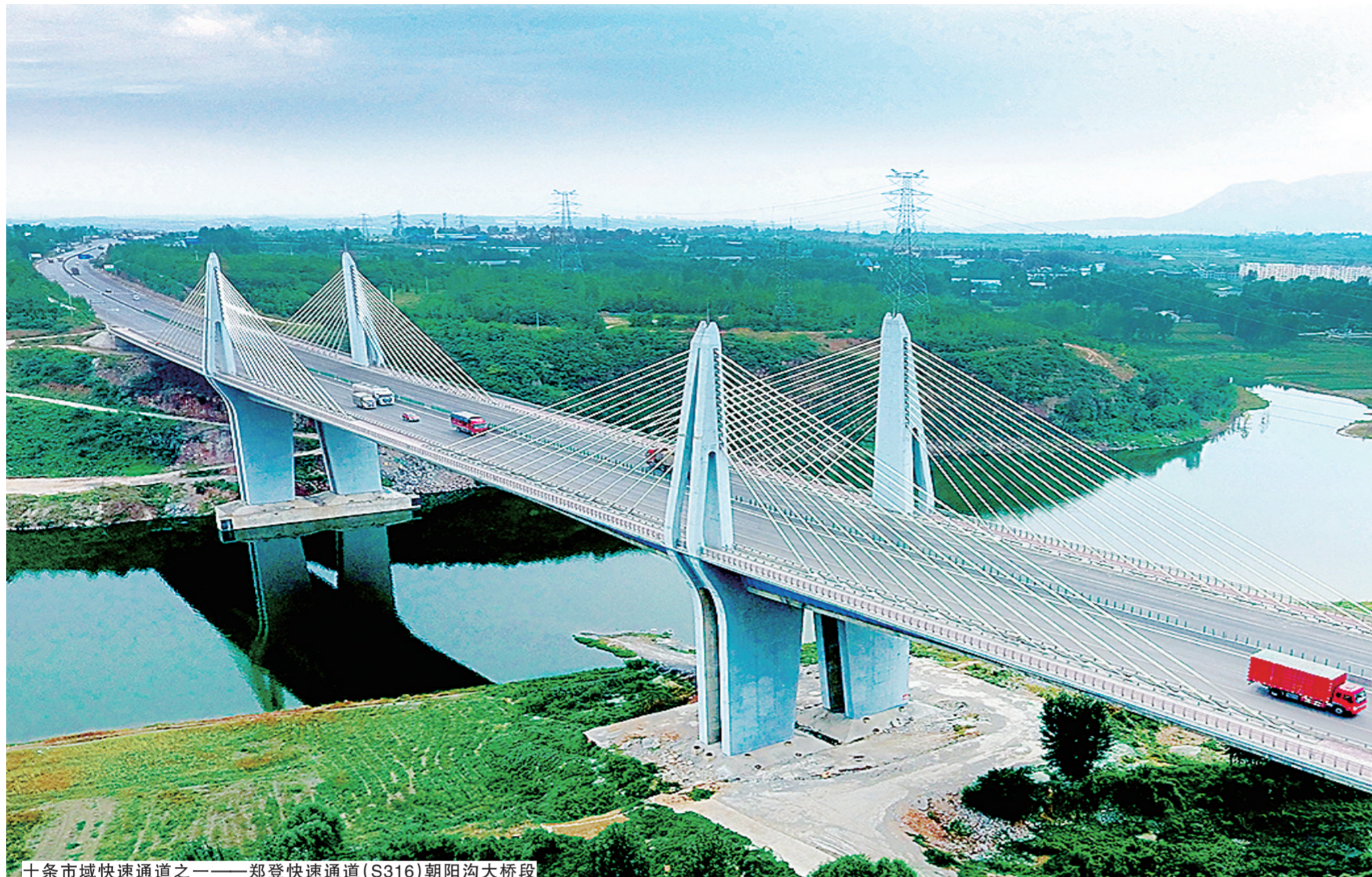
十条市域快速通道之一——郑登快速通道(S316)朝阳沟大桥段
