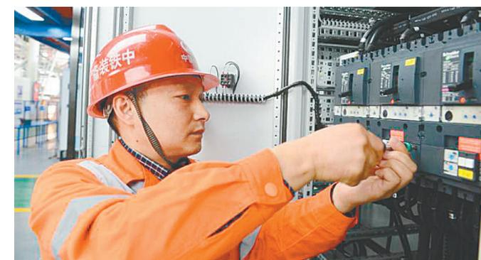
传感器线出口这个地方容易断掉。一断掉就要开舱进去更换,影响工作进度不说,人进入带压的舱内还有一定危险。”李刚说,这次他为液位传感器换上了金属管接头,以后100%不会断掉。
