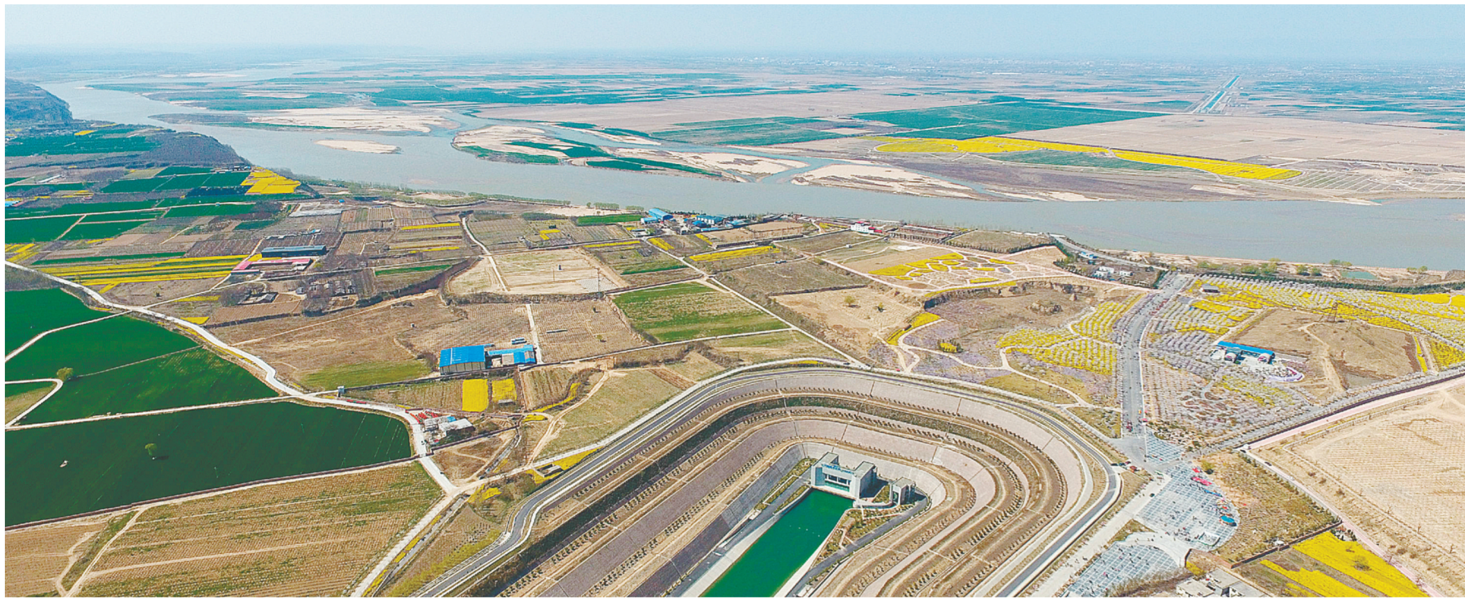
南水北调穿黄工程
