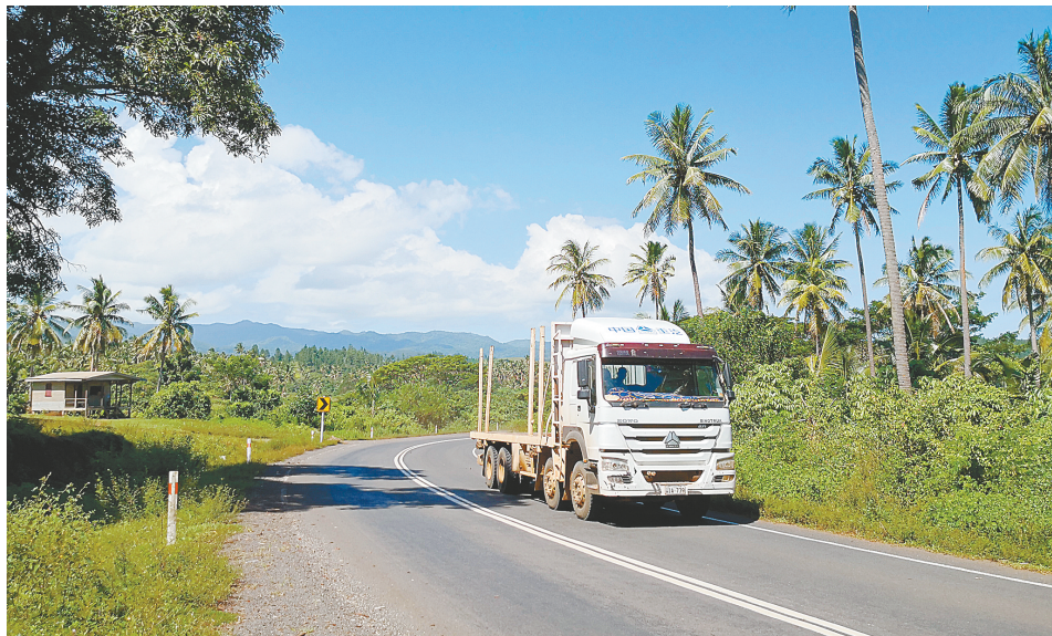
4月29日，在斐济瓦努阿岛，一辆卡车行驶在布扎贝高速公路上。瓦努阿岛是南太平洋岛国斐济第二大岛。中铁一局斐济公司在岛上修建的纳布瓦鲁高速公路和布扎贝高速公路解决了人们出行的“老大难”问题，有力拉动了经济发展，被斐济民众誉为“斐中两国友好的纽带”“共同发展致富的高速路”。 新华社记者 张永兴 摄
