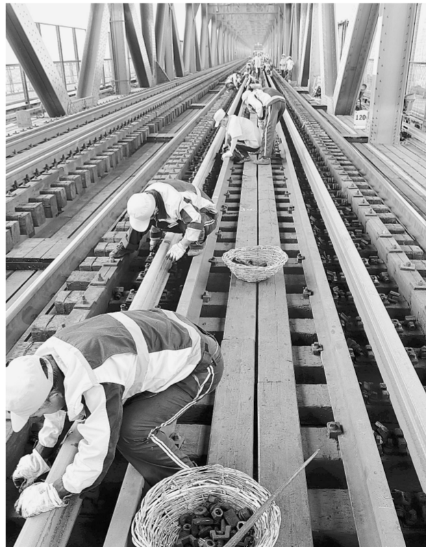
为保障铁路安全行车,6月14日,中国铁路武汉局组织200多名职工,利用铁路行车的间隙时间,更换武汉长江大桥铁路桥面的钢轨。
