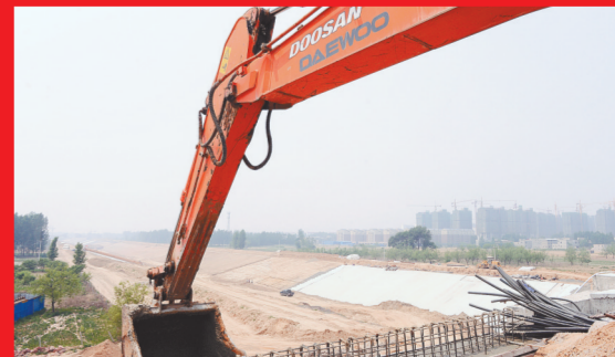
郑港六路南水北调工程
