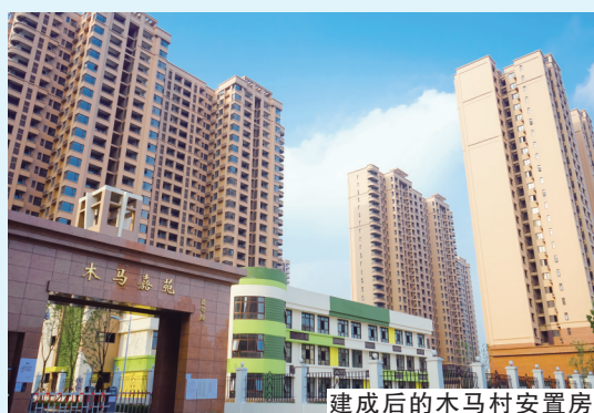
建成后的木马村安置房
