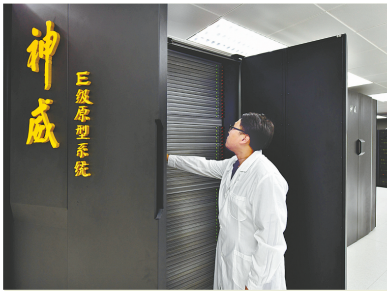
8月5日,在国家超级计算济南中心,工作人员在查看神威E级原型系统运转情况。新华社记者 郭绪雷 摄
