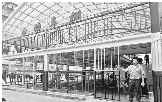
为切实解决群众“停车难、充电难”的问题,省五建社区党委,积极同物业公司沟通联络,在建西100号院29号楼南侧建立立体停车棚。经过一个月的施工,昨日停车棚基本完工,待内部装修完毕后向居民开放使用。本报记者 孙志刚 摄
