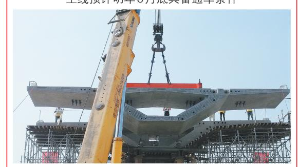
本报讯(记者 黄永东 文/ 图)昨日上午,四环线及大河路 快速化工程开始第一片预制节 段梁架设施工,在未来一年时间 内,这片预制节段梁将和其他4 万多片一起,组合拼接成"四环 大高架"。高架主线预计明年6 月底具备通车条件。
