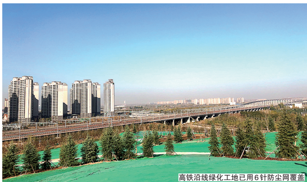
高铁沿线绿化工地已用6针防尘网覆盖
