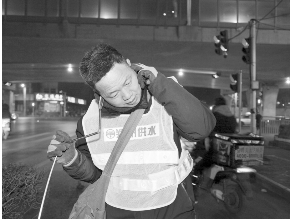
“检漏工”深夜为城市供水管线听诊。
