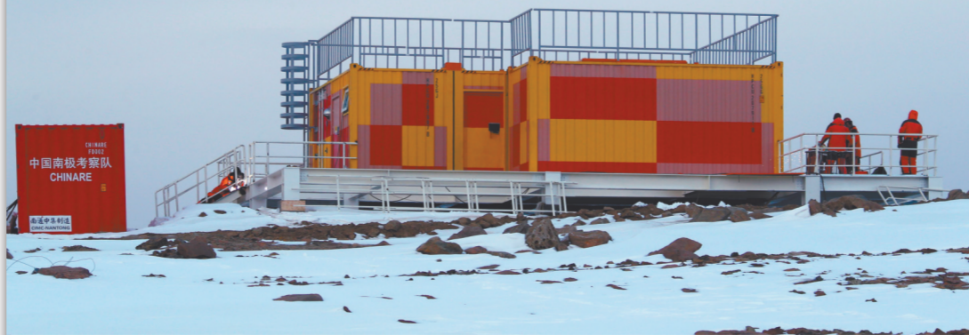
这是中山站激光雷达观测舱(2月11日摄)。中国第35次南极科学考察队日前在南极中山站顺利完成钠荧光多普勒激光雷达探测系统的安装和调试,首次同时探测到南极中层顶区大气温度和三维风场,填补了极区中高层大气探测的空白。 新华社记者 刘诗平 摄
