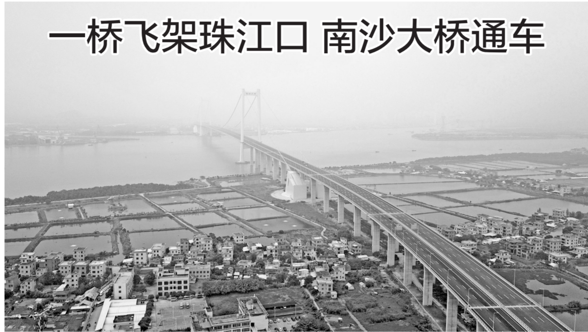
4月2日无人机拍摄的南沙大桥。当日,作为粤港澳大湾区内又一条重要过江通道的南沙大桥正式通车。南沙大桥全长12.89公里,双向八车道,设计行车速度为100公里每小时,大桥开通后可极大缓解珠江口东西两岸的交通压力。
