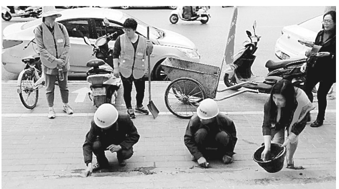
北林路街道元元社区党支部针对辖区内基础设施薄弱、道路破损严重,面向辖区单位发出“英雄帖”。河南恩泽房地产有限公司在第一时间认领服务项目,主动联系社区要求对辖区内破损路面进行修复,使得道路换新颜。本报记者 党贺喜 摄
