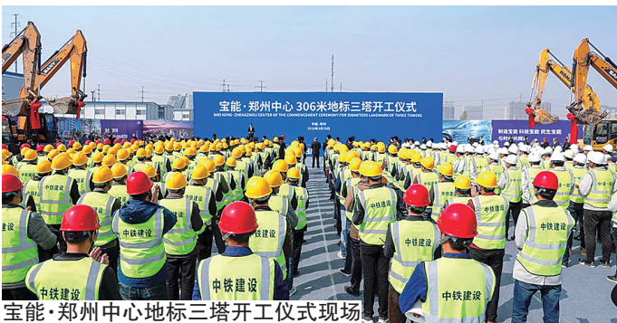
宝能·郑州中心地标三塔开工仪式现场
