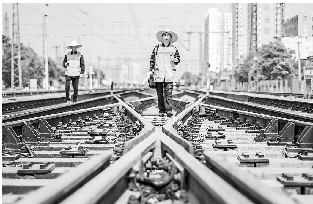
昨日中午,高温下,郑州桥工段圃田西线区间检查工区职工对陇海线圃田西站西岔区2公里线路进行巡视。
