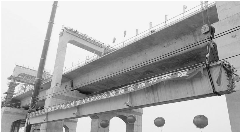
本报讯(记者 曹婷 通讯员 孙涛杰 文 丁友明 图)经过近一小时的准备,随着两台500吨汽车起重机依次将小箱梁吊至墩顶,两侧千斤顶同步牵引钢绞线将首片40米公路箱梁滑移至上层设计位置。21日13:08,由中铁大桥局承建的郑济黄河特大桥梁首片40米公路箱梁架设顺利完成。
