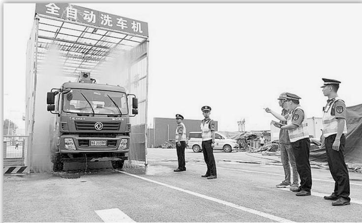
昨日,郑州航空港经济综合实验区城市管理局对全区建筑工地进行清洁检查。记者跟随执法队员来到位于华夏大道的一处工地,发现这里有一个自动洗车设备。当运输车辆经过时,喷水设施即开始向车轮多方向喷水,水流则流进了靠外侧的横向水槽,运输车辆经过工地门口的冲洗设备后,焕然一新,干干净净地驶向城市道路。
