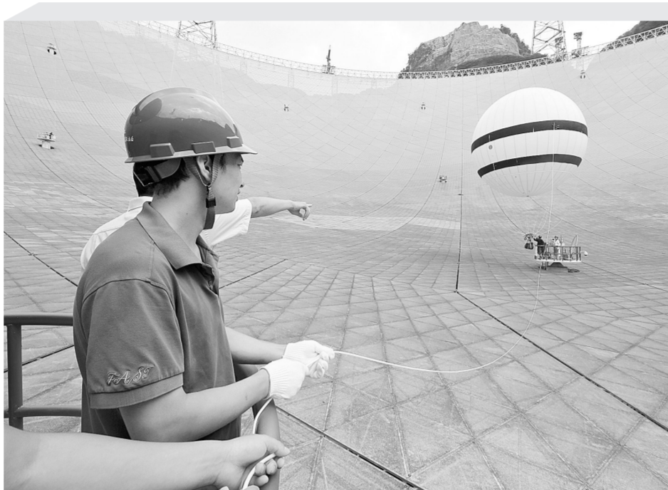
为对500米口径球面射电望远镜(FAST)反射面板进行健康体检,调试组于2017年底开始研制“微重力蜘蛛人”。该方案使用一个直径7.6米的氦气球将作业人员体重减少到FAST反射面板能够承受的重量,使得作业人员能够到达望远镜反射面任意地方执行巡检和维护作业。近日,“微重力蜘蛛人”方案进入实验阶段,“蜘蛛人”也于8月30日首次亮相“天眼”进行作业实验。 新华社发
