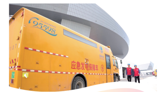
保电人员在开幕式现场巡视供电设备
