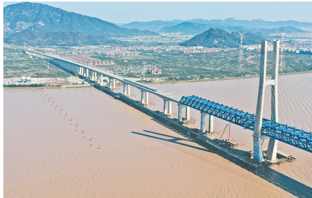
11月26日，杭台高铁首趟运行试验列车驶过台州椒江特大桥(无人机照片)。当日，随着G5501次首趟运行试验列车从绍兴北站出发驶向台州方向，我国首条民营控股高铁——杭台高铁开始试运行，进入开通运营倒计时阶段。杭台高铁是国家沿海铁路快速客运通道的重要组成部分，连接杭州、绍兴、台州三地，北起杭州东站，利用杭甬高铁至绍兴北站，之后新建正线至台州市温岭站，线路全长约266.9公里。新华社记者 黄宗治 摄
