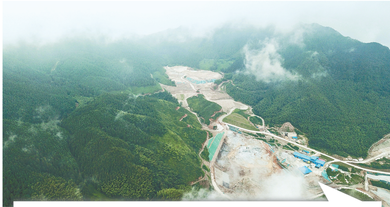
8月15日拍摄的湖南平江抽水蓄能电站建设现场（无人机照片）。
