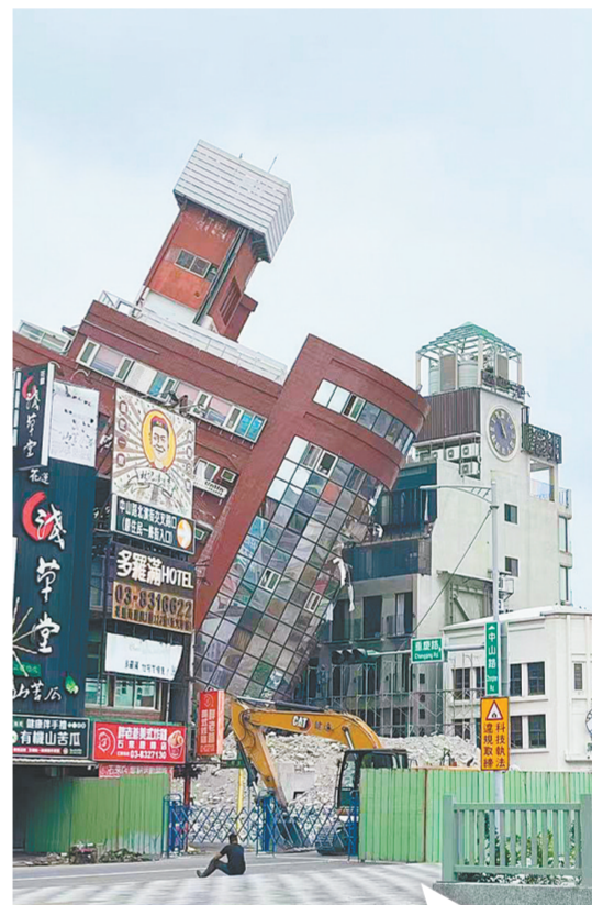
这是4月5日上午拍摄的位于花莲市区的天王星大楼。大楼将从正面玻璃开始，由上至下进行拆除。 新华社记者 赵博 摄
