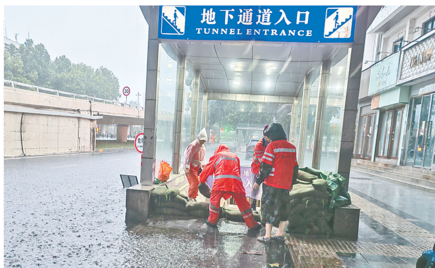
7月8日早上6:30,紫荆山花园路地下通道西侧出入口,防汛应急人员利用预设防汛沙袋对通道口进行封堵,确保人行地下通道安全。
