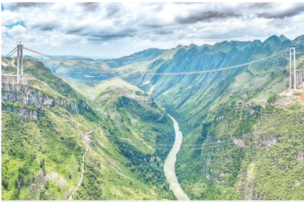
7月7日拍摄的建设中的花江峡谷大桥(无人机照片)。近日，贵州花江峡谷大桥建设加快推进，正有序进行大桥主缆索股架设施工。花江峡谷大桥是贵州六安高速公路的控制性工程，全长2890米，主桥桥面与谷底的北盘江水面垂直高度达625米。大桥建成后，将超越北盘江大桥，成为世界第一高桥。
