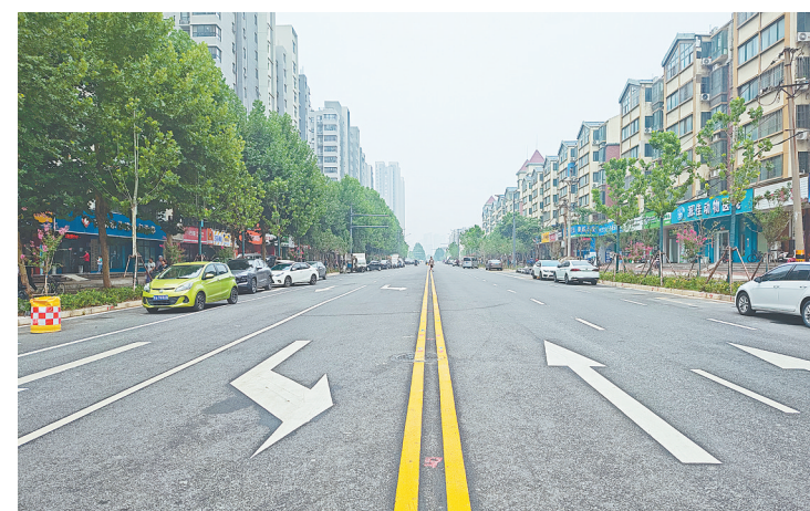
濮河路道路标识标线施划已完成
