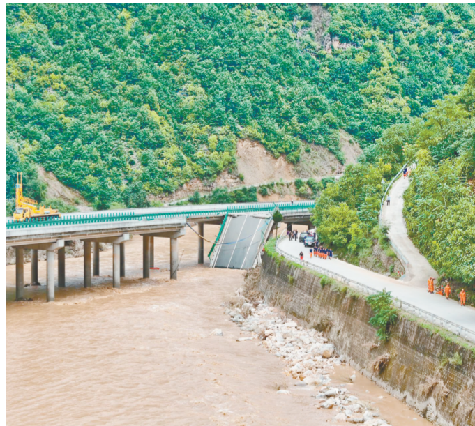
7月20日在陕西省商洛市柞水县境内拍摄的丹宁高速水阳段山阳方向K46+200处坪村二号桥垮塌现场(无人机照片)。新华社记者 赵英博 摄
