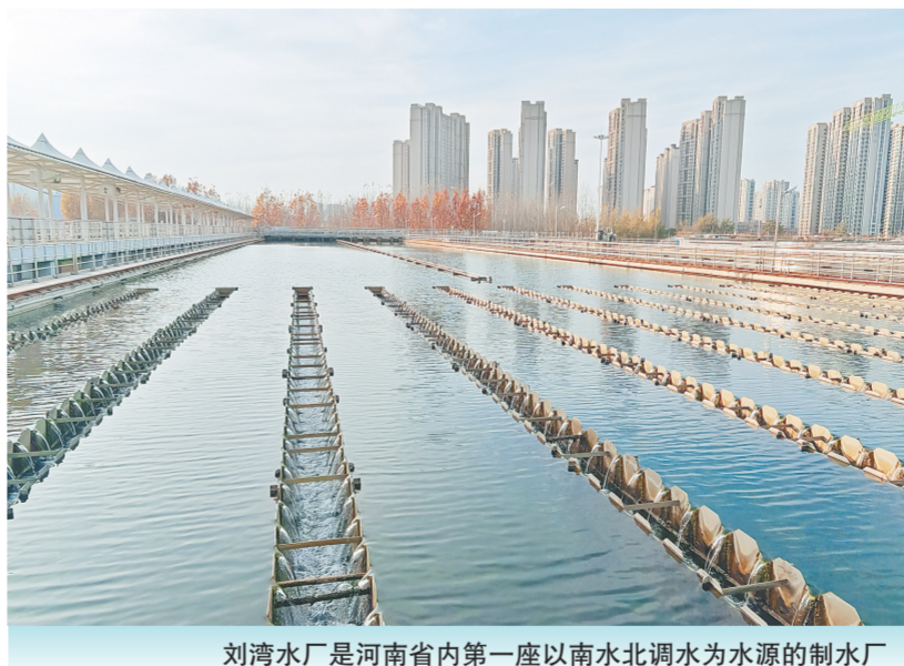
刘湾水厂是河南省内第一座以南水北调水为水源的制水厂
