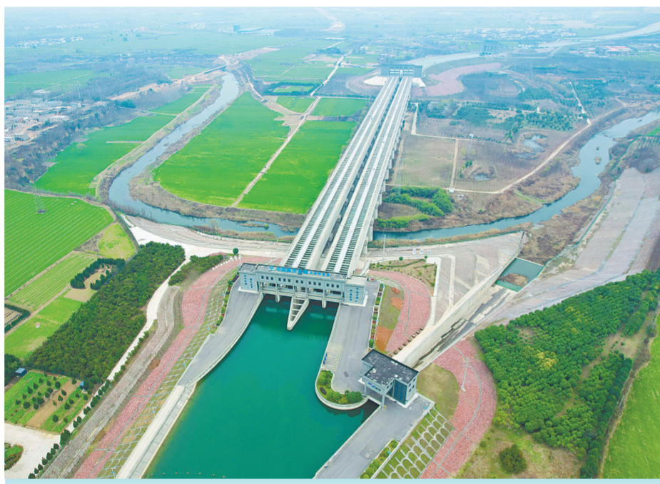
南水北调双泊河渡槽全景
