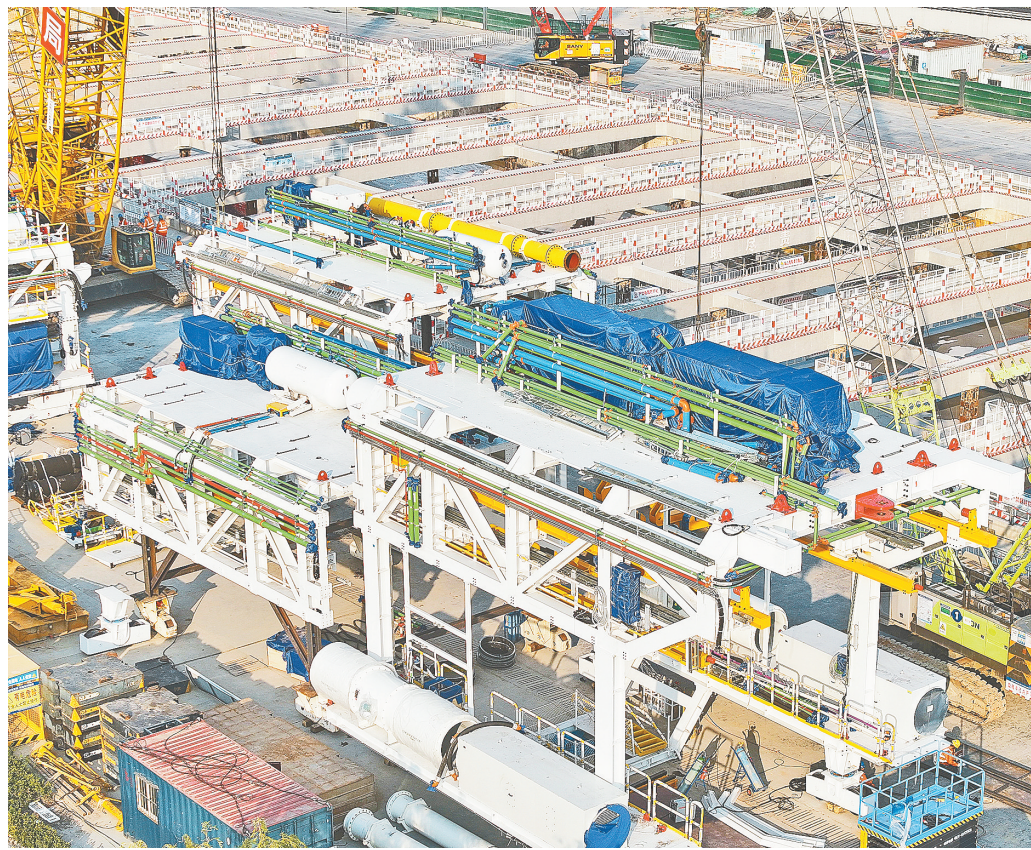
12月17日在江苏南通拍摄的盾构机“江海号”台车组装施工现场（无人机照片）。
