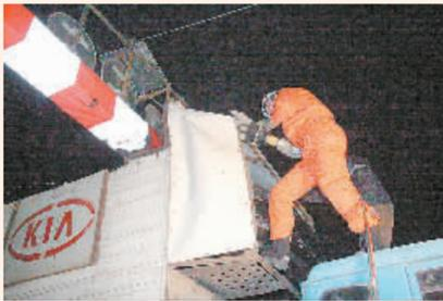
20日晚9时左右,一辆运输汽车的集装箱车因车身太高,沿商都路由东向西通过立交桥时被卡住,动弹不得。晚10时许,市消防支队管城大队一中队的10余名消防战士赶到现场,利用切割机、液压剪,将超高的风翼剪掉。晚上10时45分,被卡货车从标杆下倒了出来。随后,司机在交警的指引下绕道而行。
