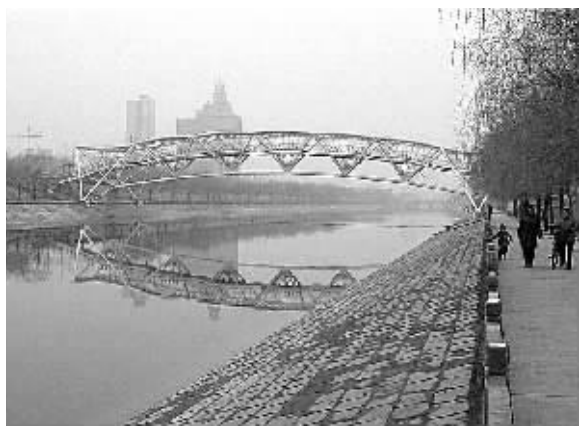
记者昨日在东风渠农业路至经三路河段看到,原来污水长流的东风渠经过截污清淤、硬化河岸等综合整治,现在渠内已经注入了清水...
