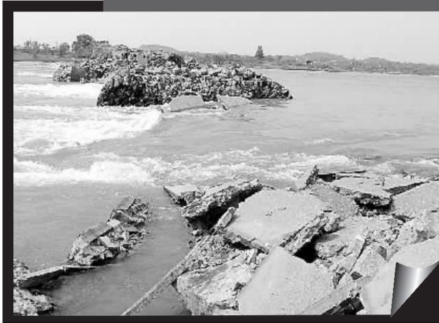
佛罗大桥1988年建成投入使用,大桥长355.2米、宽8.5米、高7米。由于采用片石拱桥结构建成,整座桥没有用一根钢筋。桥倒塌后,两边的群众要通行只能临时坐机帆船。
