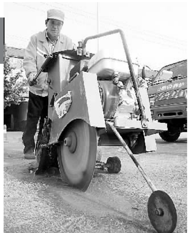
道路养护人员正在处理路面网裂、龟裂。
