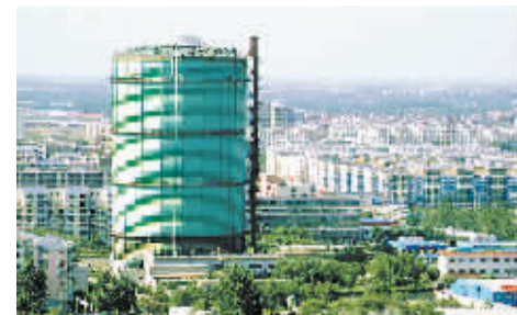
北郊天然气储气罐
