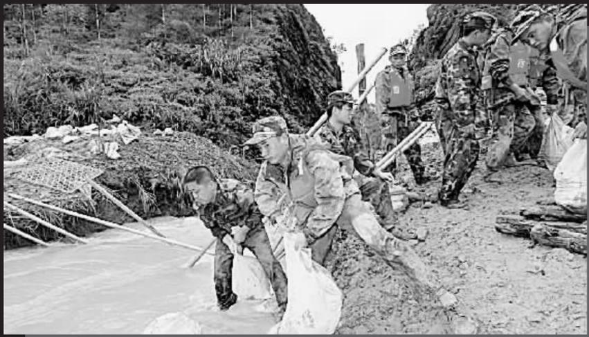
6月11日,驻兴宁市的部队官兵在大堤内侧封堵出水口。6月10日凌晨,广东省兴宁市水口镇邹水水库因连降暴雨,大堤土基被倾泻的洪水掏出一个大洞。险情发生后,梅州市和兴宁市迅速调遣部队官兵、工程人员和群众等600多人赶到现场护堤堵漏。经过48小时的日夜奋战,终于排除险情,保住了下游7500多名群众的生命财产安全。
