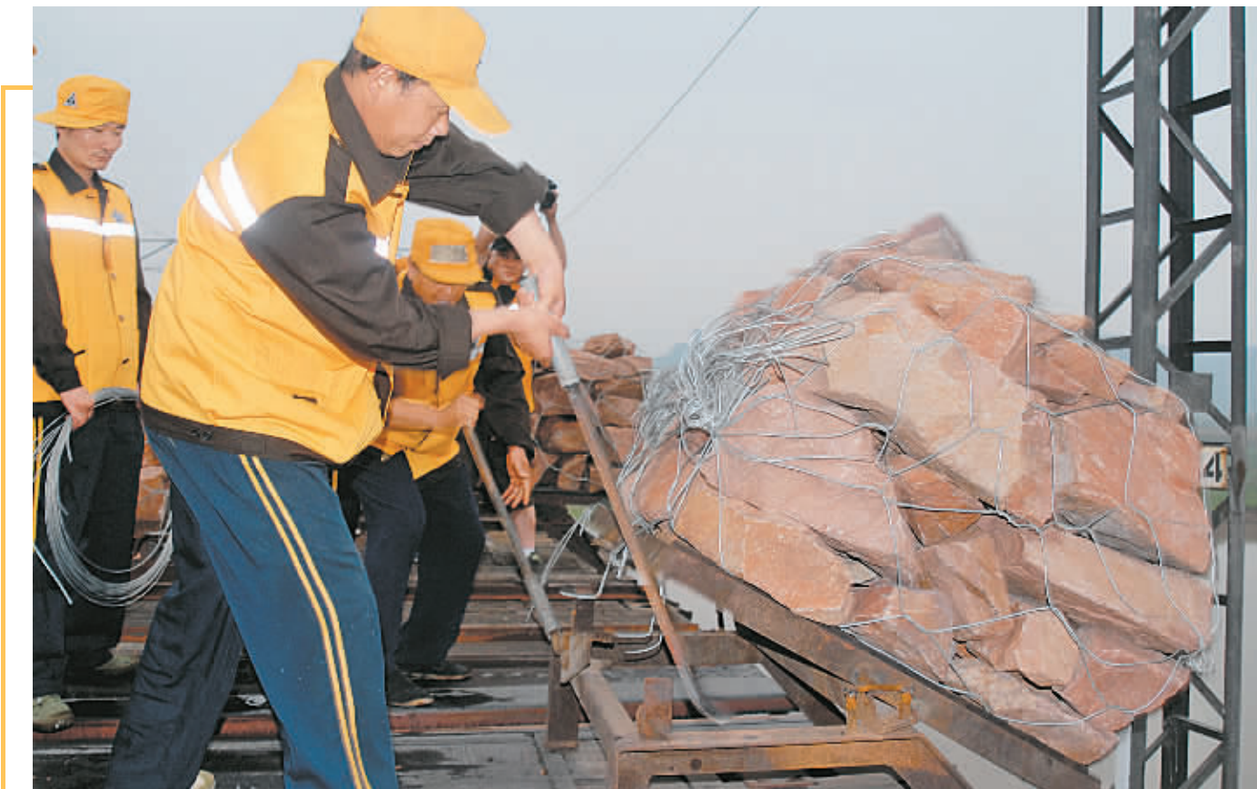
本报讯(记者 王文霞 通讯员 王峰文/图)昨日18时30分,一列铁路专用防洪抛石车缓缓驶上京广黄河铁路大桥,它以每小时5公里的速度,从京广线黄河铁路大桥上成功抛下180笼近180立方米石块。郑州铁路局2007年京广线黄河铁路大桥抛石防洪度汛施工,由此拉开序幕。
