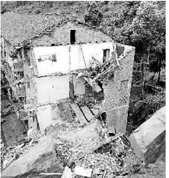
6月19日,四川达州通川区通达化工有限公司一幢职工宿舍楼被重达数吨的山石砸垮。 新华社发
