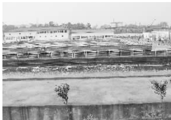
郑州市污水处理厂污水收集管网日前全线贯通,该市原规划区内的生活污水全部通过污水管网收集输送至污水处理厂,集中处理后达标排放。
