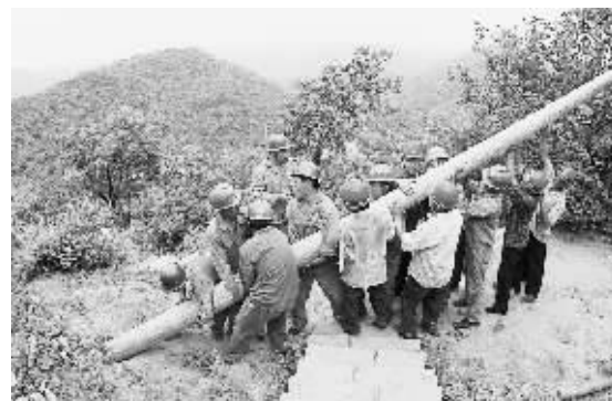
荥阳“户户通电”工程今年投资额为1200万元,工程竣工后将根本解决该县无电村、盲点村的用电问题。图为荥阳电业局职工全力施工。 李利强 李建文 摄
