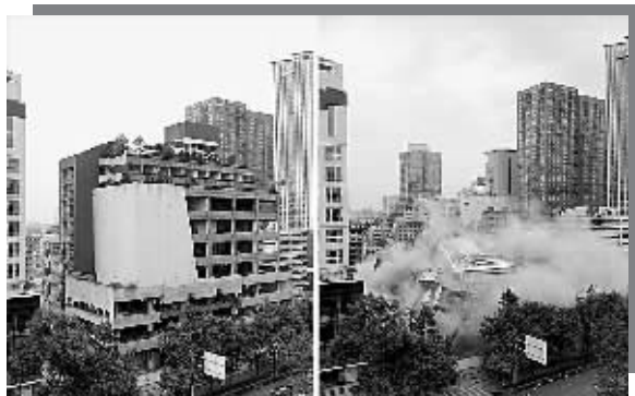
图为成都百货大厦爆破前与爆破时的对比照片。7月5日,位于成都市中心春熙商圈的成都百货大厦成功爆破,拆除后将为商圈的发展腾出更大空间。
