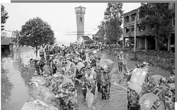
7月4日,武警荆门市支队官兵在荆门市何集筑堤。连日的强降雨,使湖北省荆门市白沙滩河堤决堤50多米,经过10小时的连夜抢险,成功将洪水阻挡。
