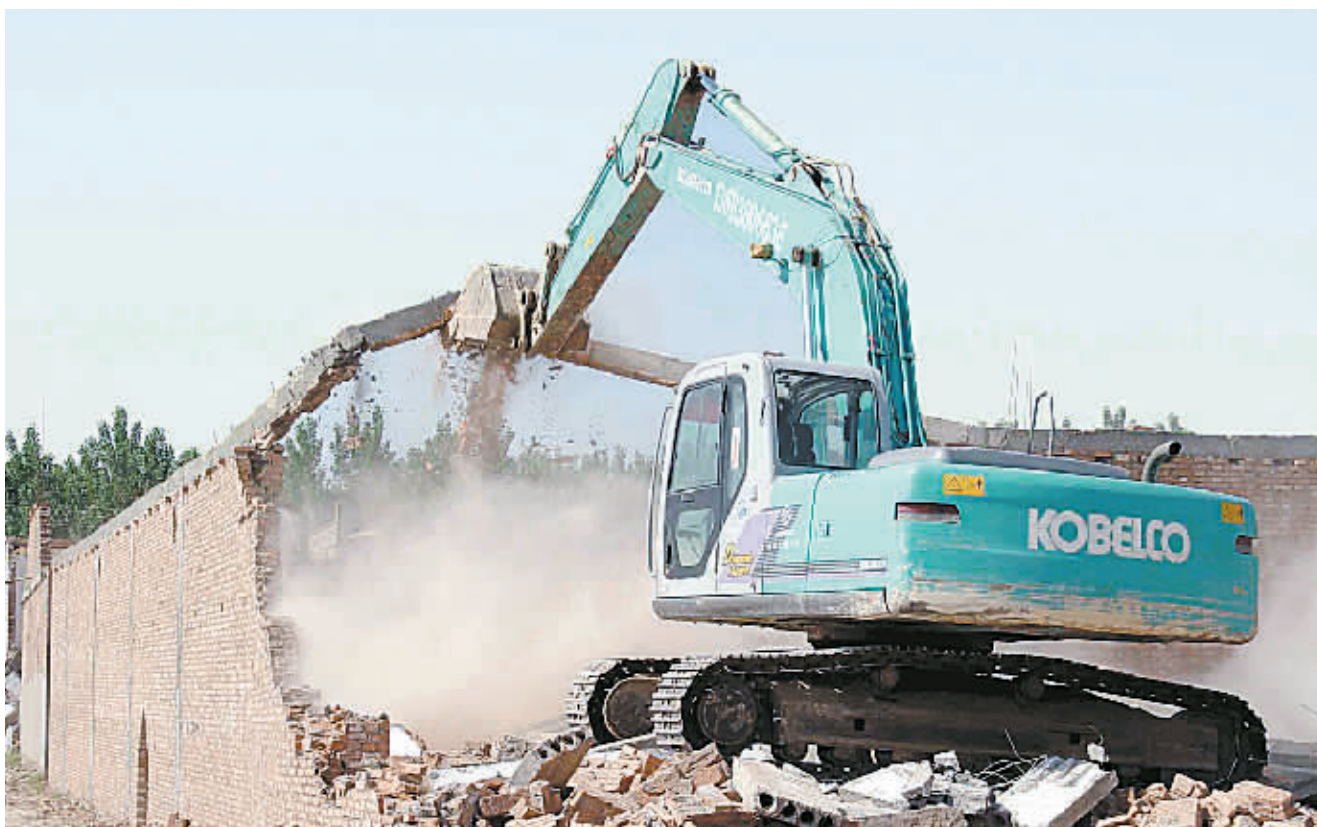
金水区执法人员正在拆除道路两侧非法占地建筑物。今年上半年以来,该区土地执法监察结案108宗,强制拆除违法用地4宗,拆除建筑面积1.3万平方米。
