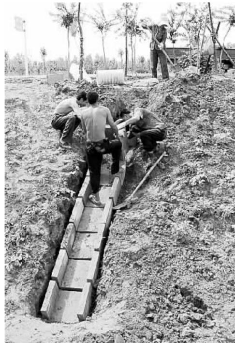
连日来,中牟县水利部门组织人力对郑开大道路面横向排水工程进行施工,以使大道汛期路面不积水,保证道路畅通。本报记者 许大桥 摄
