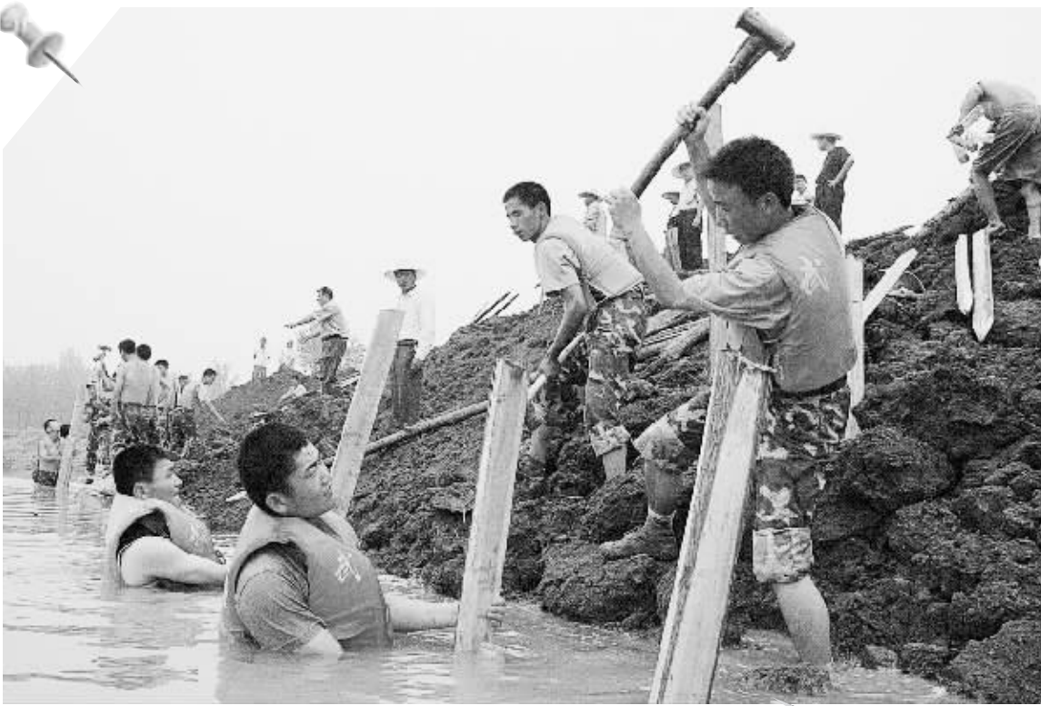
7月12日,武警安徽总队直属支队官兵正在打桩加固大堤。当日凌晨,安徽阜南县境内的淮河南岸岗圩、保庄圩大堤先后出现约2米宽的滑坡。武警安徽总队直属支队200名官兵经过16小时的奋战,确保了大堤的安全。
